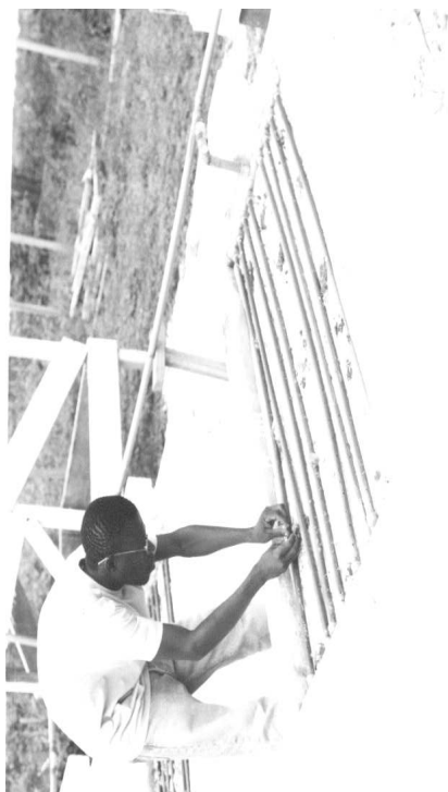
Photographie 2: Positionnement du tissu géotextile
