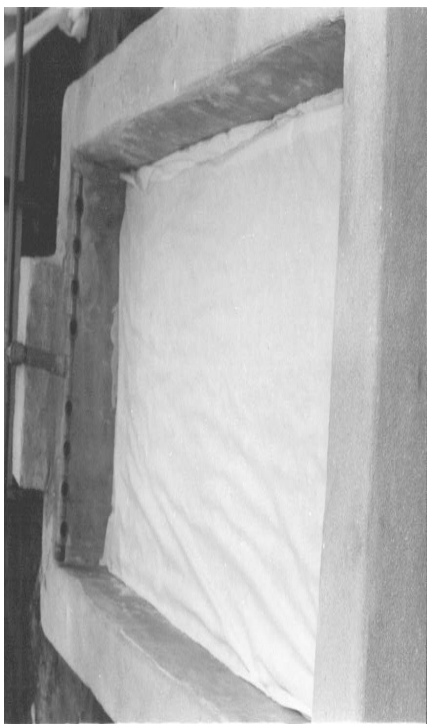
Photographie 2: Positionnement du tissu géotextile
